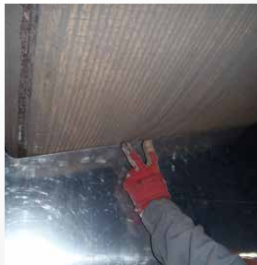
Проверка сварного профиля мельницы Loesche
