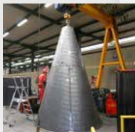
Ремонт конуса угольной мельницы с помощью CDP®
