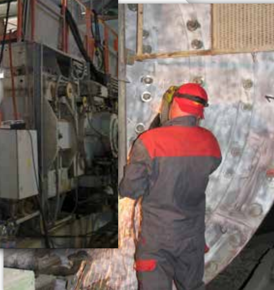
Ремонт трещин шаровой мельницы
