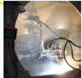
Ремонт стола с помощью MTC 8338
